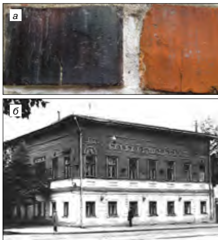
Рис. 8. Фрагмент кирпичной кладки дома купца Дротоевского, 1837 г., Казань, ул. Карла Маркса, 56/11. Сильно обожженный «железняк» (слева) и рядовой кирпич (справа) – а; двухэтажный дом с каменным первым и деревянным вторым этажом построен по проекту архитектора Ф.И. Петонди (1837 г.), принадлежал помещику Я.Г. Дротоевскому. В настоящее время ведется реставрация этого объекта культурного наследия федерального значения. По ее завершении в доме будет размещаться Школа юных архитекторов при КГАСУ – б
