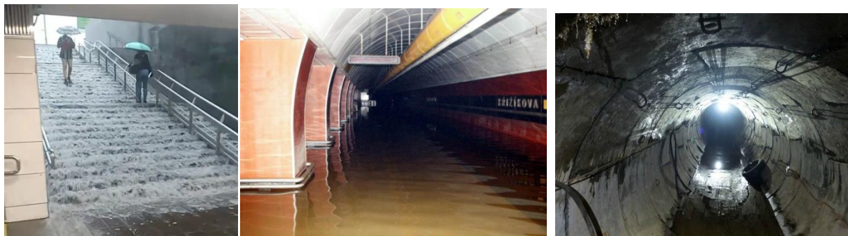
Рис. 1. Затопление метро водой
