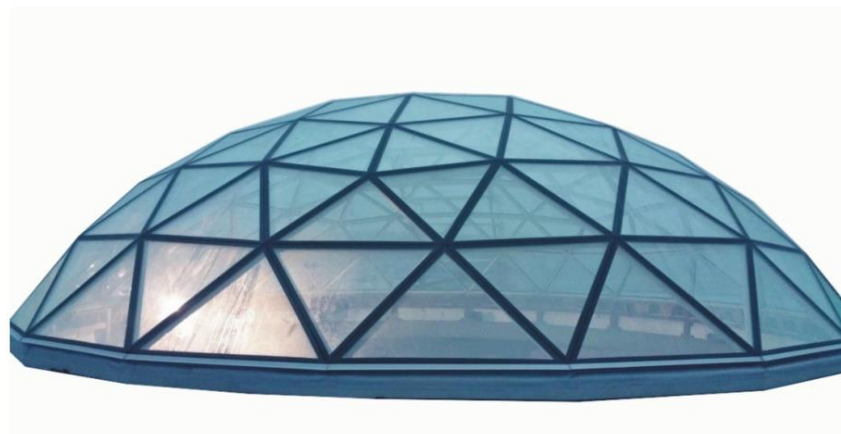
Рис. 5. Купол, изготовленный из стекло- и углепластика
