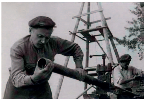
Строительство колхозного водопровода
