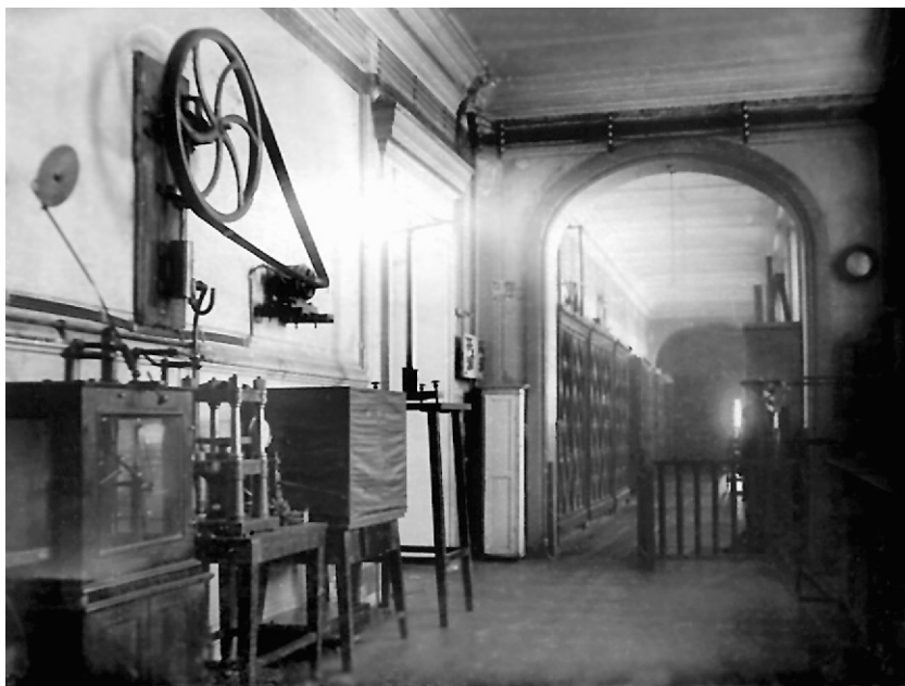
Фото 2.3. Коридор второго этажа физического отделения
