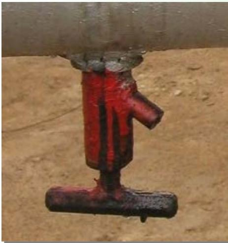
Пробоотборник предназначен для отбора проб жидкости, поступающей из скважины.
