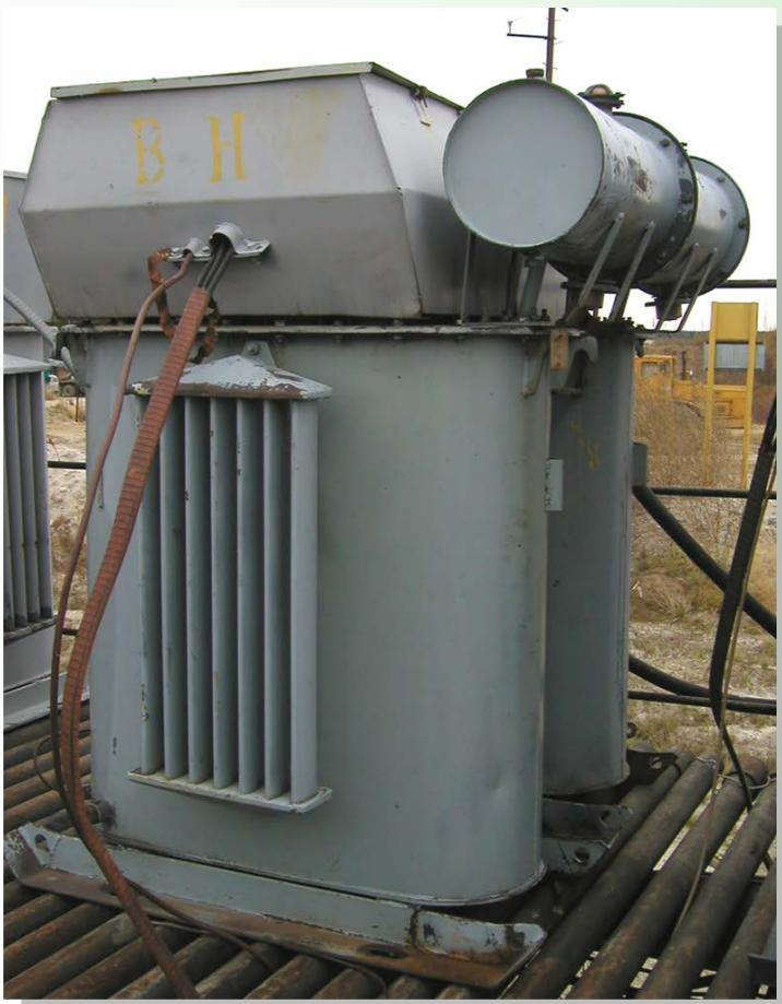
**Электрические трансформаторы преобразуют напряжение источника питания в напряжение необходимое для двигателей насосов.**
