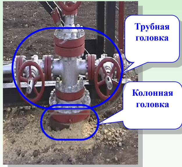
**Трубная головка устанавливается на колонную головку**
