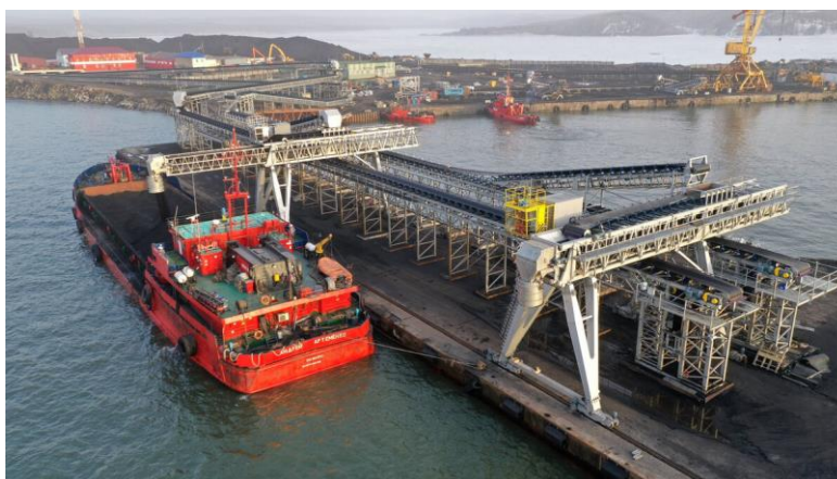
Рис. 2. Автоматизированный дробильно-сортировочный комплекс конвейерного типа
