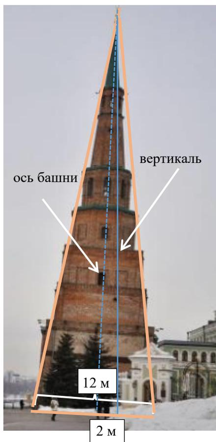
Рис. 1. Отклонение оси башни Сююмбике от вертикали
