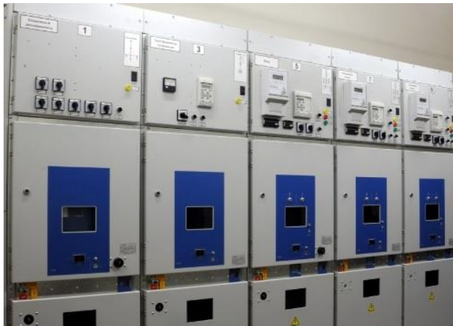
Рисунок 8 - Внешний вид шкафов КРУ
