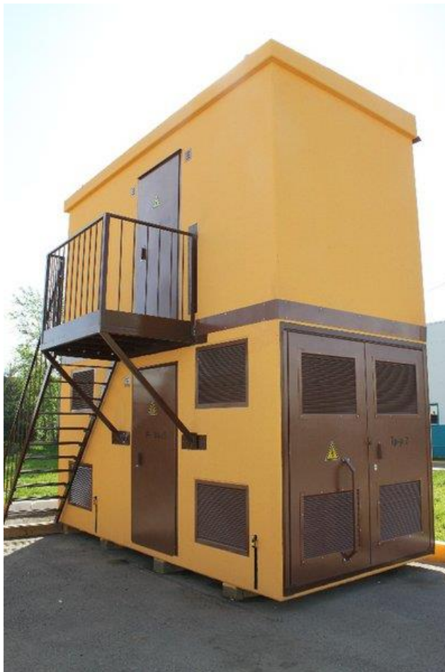
Рисунок 7 - Двухэтажная подстанция в бетонной оболочке
