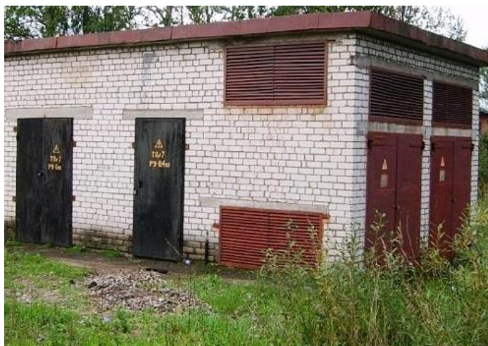
Рисунок 2 - Внешний вид трансформаторной подстанции 6-10-35/0,4 кВ
