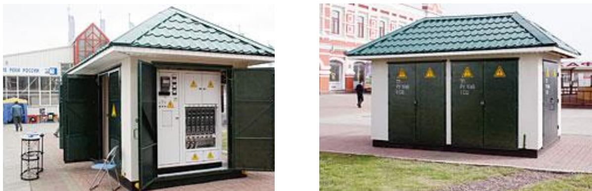
Рисунок 4 - Двухлучевая двухтрансформаторная КТП наружного обслуживания в железобетонном контейнере (2КТП-БК)
