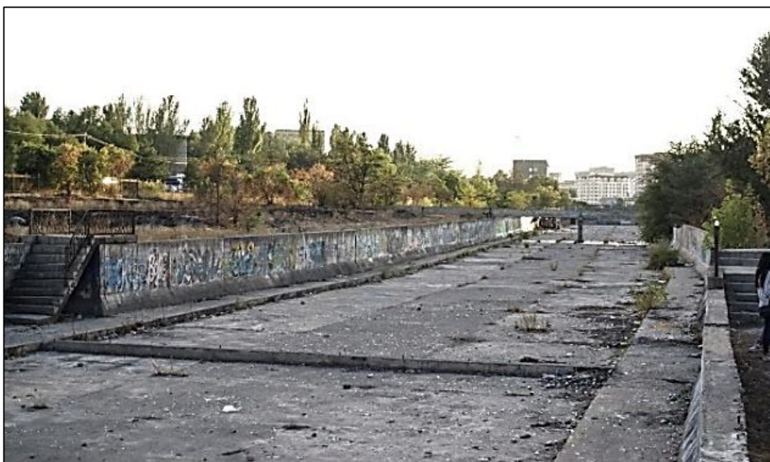
Рис. 8. Бетонное русло Южного Чуйского канала
