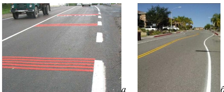
Рис. 9. Применение «виброполос» (а) и «зон успокоения» (б)
