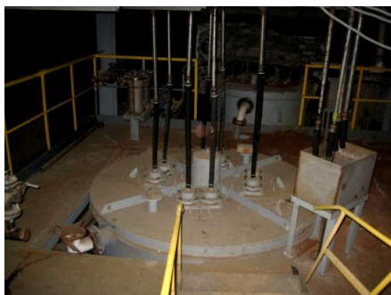
Рис. 5. Холодильник серной кислоты с фторопластовыми охлаждающими элементами (вид сверху).
