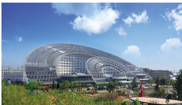
Рис. 1. Офисное здание "Sundail" в городе Дэчжоу, провинция Шаньдун
