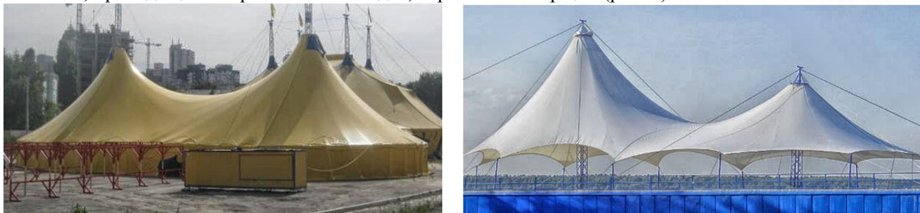
Рис 2. Примеры образования складок, перекосов и морщин в тентовых шатровых оболочках при традиционном способе формообразования и раскроя
