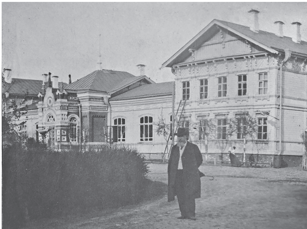
Ил. 2. Вид железнодорожного вокзала с привокзальной площади. Фото из личного семейного архива Ивана Рейпольского Fig. 2. View of the railway station from the station square. Photo from the personal family archive of Ivan Reypolsky
