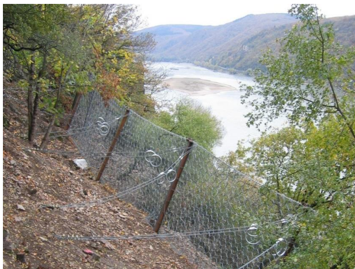
Рис. 4.15. Сквозное противоселевое заграждение на основе сетки
