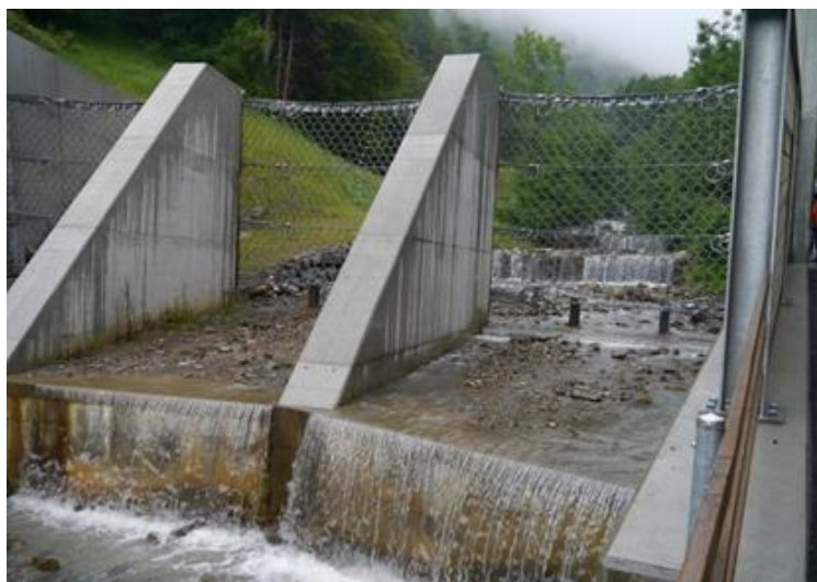
Рис. 4.14. Противоселевой барьер в русле ручья Гренбах в Мерлигене
