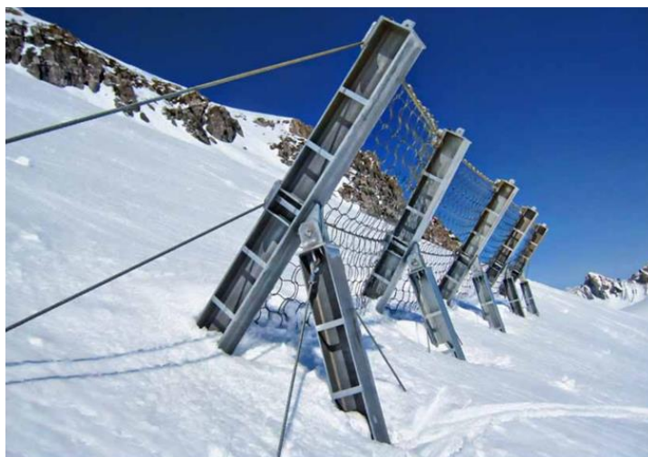
Рис. 4.24. Сетчатый противолавинный барьер
