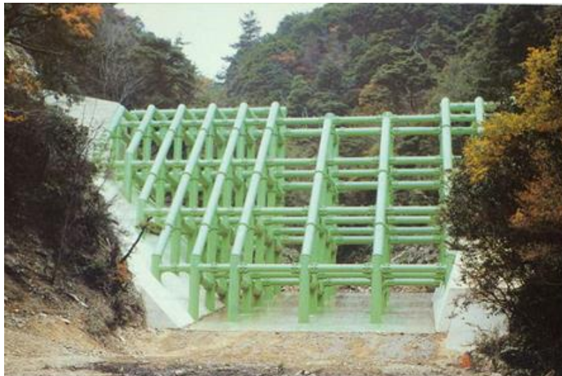
Рис. 4.12. Объемное стержневое сооружение
