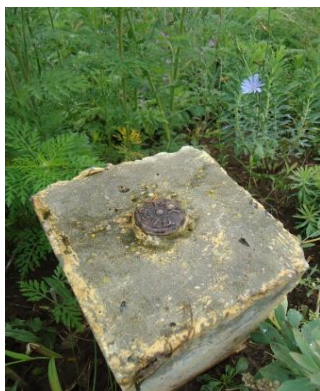
Рис. 43. Опорные и деформационные знаки
