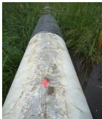
Рис. 43. Опорные и деформационные знаки
