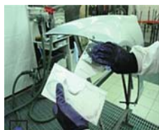
Рисунок 3. Нанесение шпатлевки на участок повреждения
