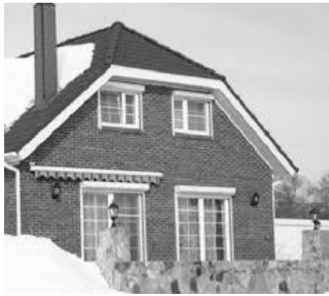
Рис. 35. Полувальмовая (голландская) крыша
