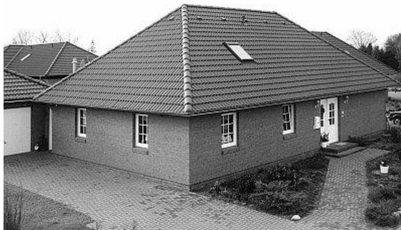
Рис. 34. Вальмовая крыша
