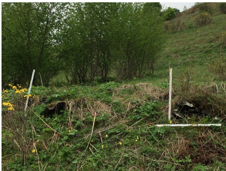
Рис. 2 – Каменная подпорная стена земледельческой террасы, РСО-Алания (фото В. Чшиева)
