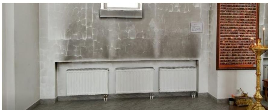
Рисунок 3 – Копоть на поверхности стены
