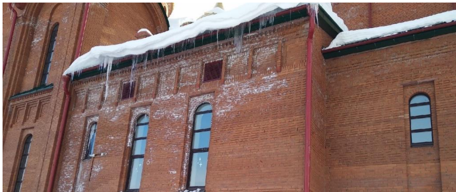
Рисунок 2 – Вытяжная и приточная решетка вентиляционной системы
