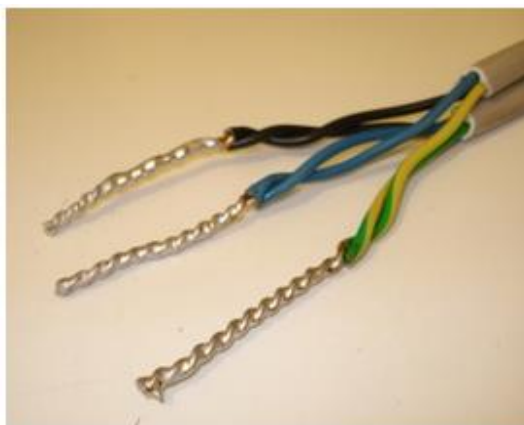
Рис.9. Пайка скруток
