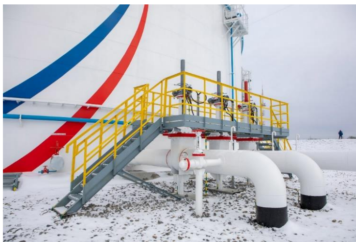
Рисунок 1. Трубопроводы технологической обвязки резервуара
