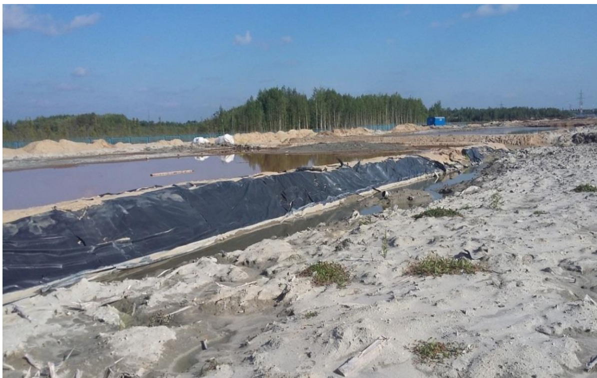
Рисунок 2. Буровые отходы после размещения в шламонакопителе
