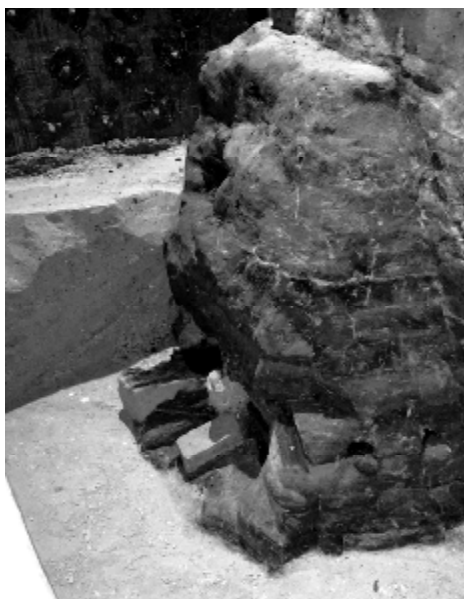
Рис. 4. Руинированный фрагмент фундамента деревоземляного бастиона Петропавловской крепости (строительство 1703 г.) (иллюстрация авторов)
