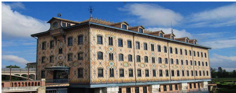
Рис. 4. Многоэтажное здание со стальным каркасом. Шоколадная фабрика Менье. Нуазье-на-Марне близ Парижа. 1871–1872 гг.
