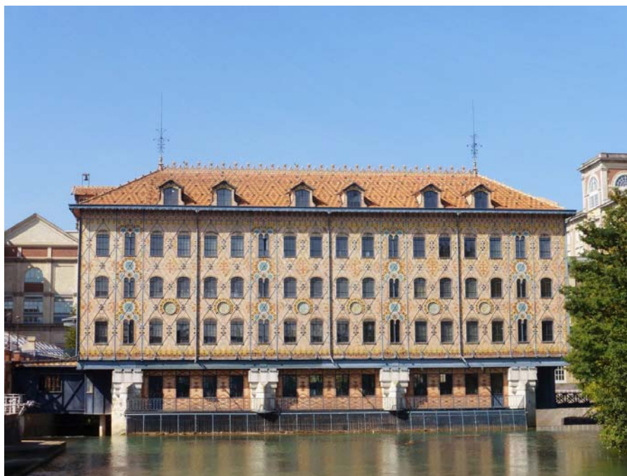
Рис. 6. Многоэтажное здание со стальным каркасом. Шоколадная фабрика Менье. Нуазье-на-Марне близ Парижа. 1871–1872 гг.
