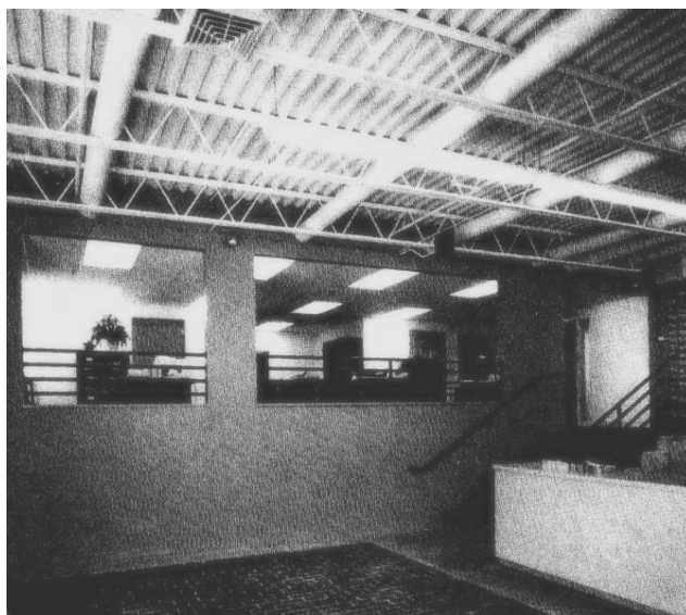
Рисунок 1. Общий вид конструкции подвесного потолка и некоторых элементов систем жизнеобеспечения административного здания в процессе монтажа.
