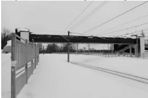
Рисунок 2 – Общий вид пешеходного моста
