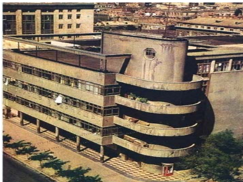
Рис. 2. Здание «Азернешр», г.Баку
