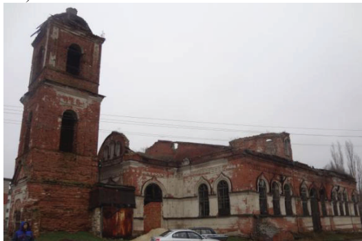
Рис. 1. Общий вид обследуемого здания церкви на момент обследования
