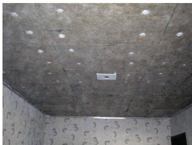
Рис. 2. Звукоизоляция потолка с помощью минераловатных полужестких плит.
