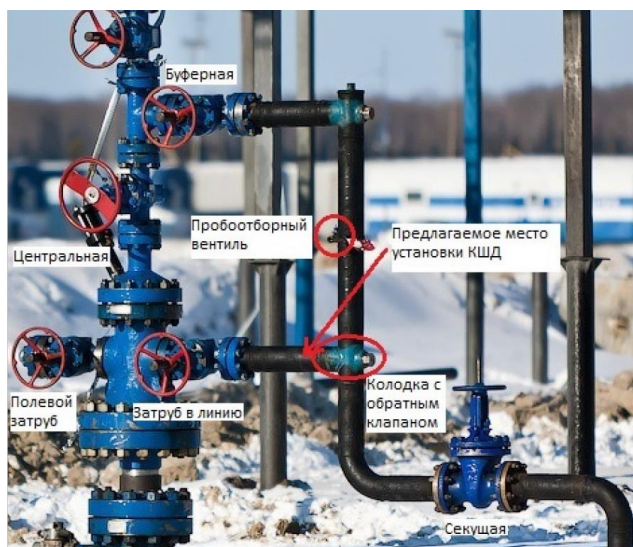
Рисунок – Пример расположения КШД на скважине
