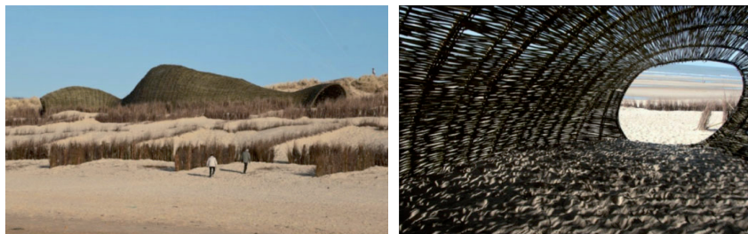
Рис. 1, 2. Marco Casagrande построил «песчаного червя» среди дюн на пляже Wenduine в Бельгии. Это 45-метровое строение в длину и 10-метровое в ширину – пример сенсорной архитектуры. Сплетено оно в основном из ивы. Этот необычный тоннель показывает своим гостям удивительную игру света и тени. Финский художник Marco Casagrande считает, что дизайн не должен заменять реальность, создаваемое здание должно «вырастать», реагировать на окружающую среду, быть отражением жизни, а также быть самим собой, как и любое другое живое существо
