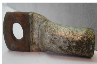
а) до очистки
