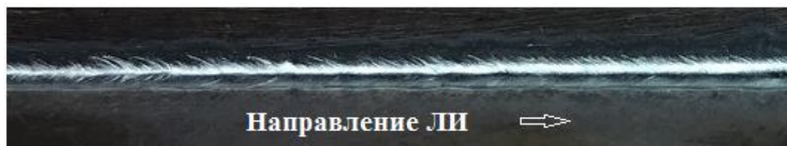
Рисунок 4. Фотография сварного шва.
