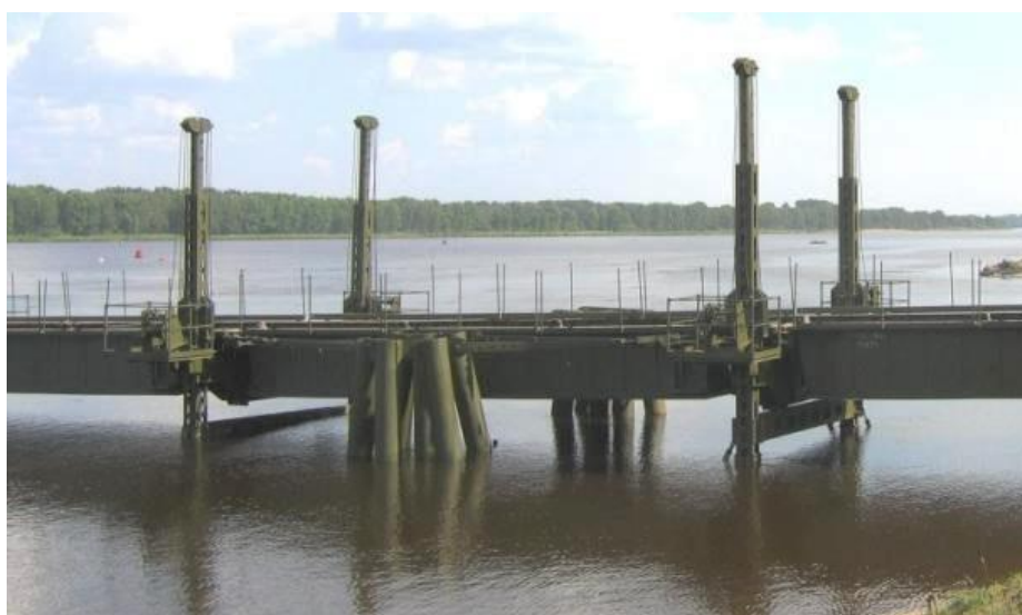
Рис. 29. Тормозное пролётное строение МЛЖ-ВФ-ВТ, выполненное в третьем пролёте береговой части
