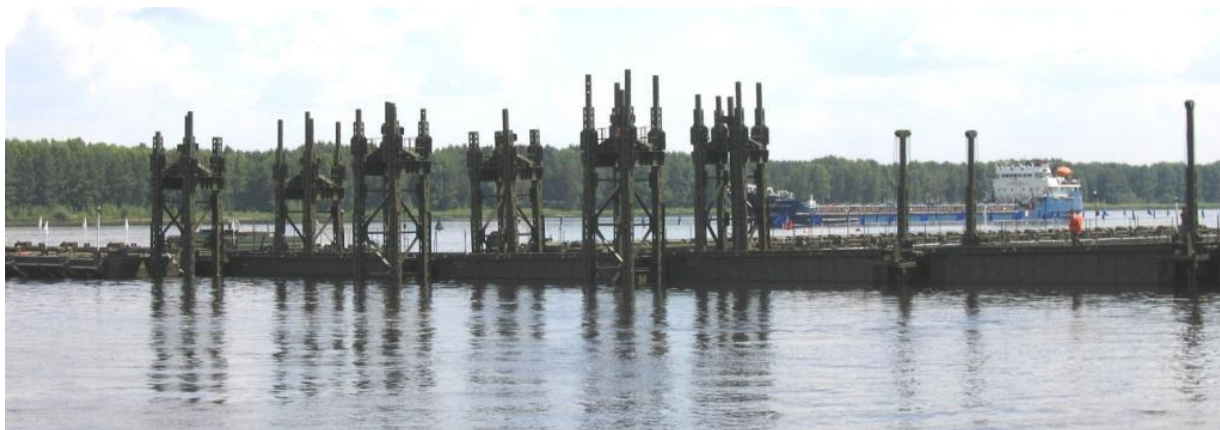
Рис 27. Общий вид башенных и ограничительной подъёмных опор в составе береговой и переходной частей моста
