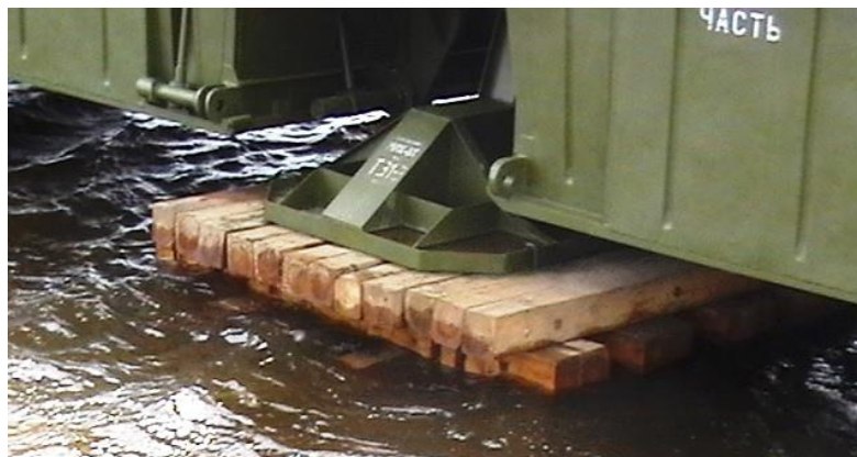
Рис. 24. Береговая опора со свайным фундаментом
