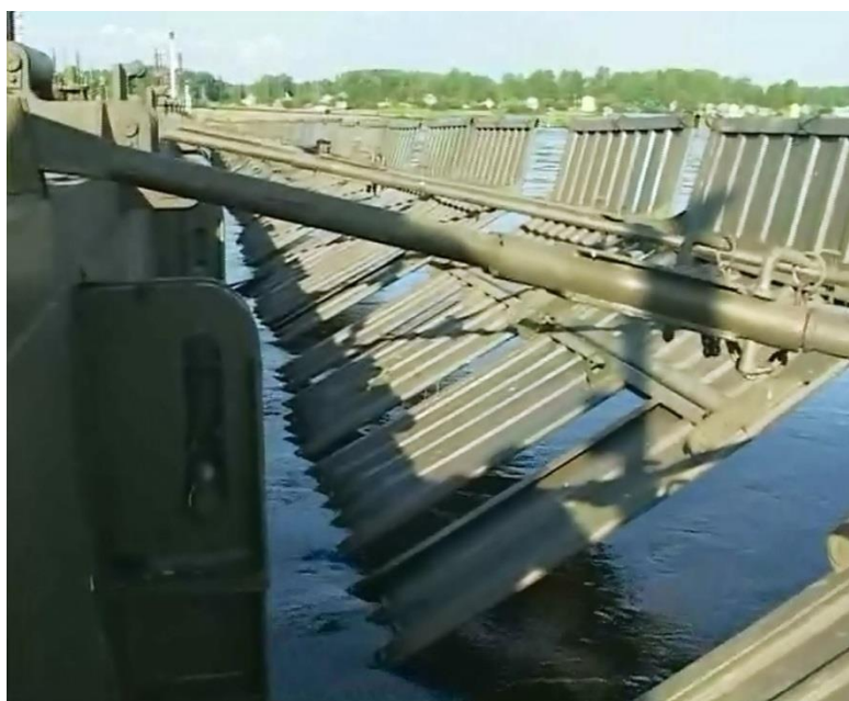
Рис. 19. Щиты-обтекатели понтонов марки К в рабочем (откинута) положении
