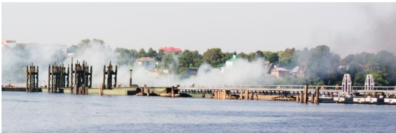
Рис. 35. Стыковка речных частей из имущества НЖМ-56 и МЛЖ-ВФ-ВТ в русле реки через береговые и переходные части
