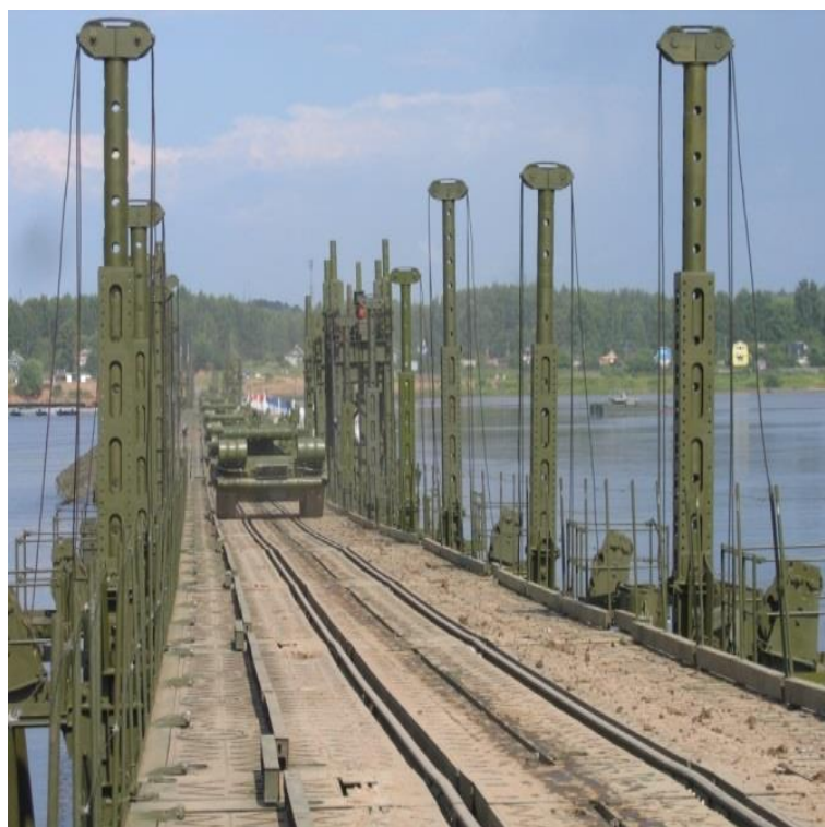
Рис. 25. Вид плоских подъёмных опор с проезжей части моста
