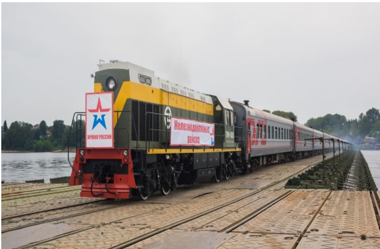
Рис. 12. Речная часть моста-ленты МЛЖ-ВФ-ВТ
