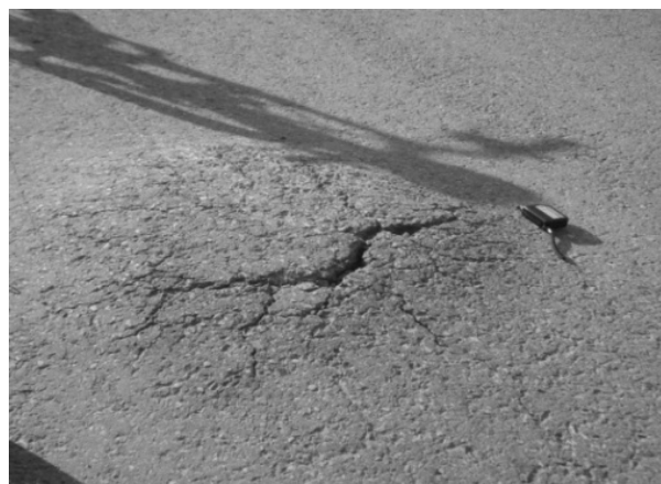
Рис. 3. Бугор пучения на улице Интернациональной (июнь 2012г.)
