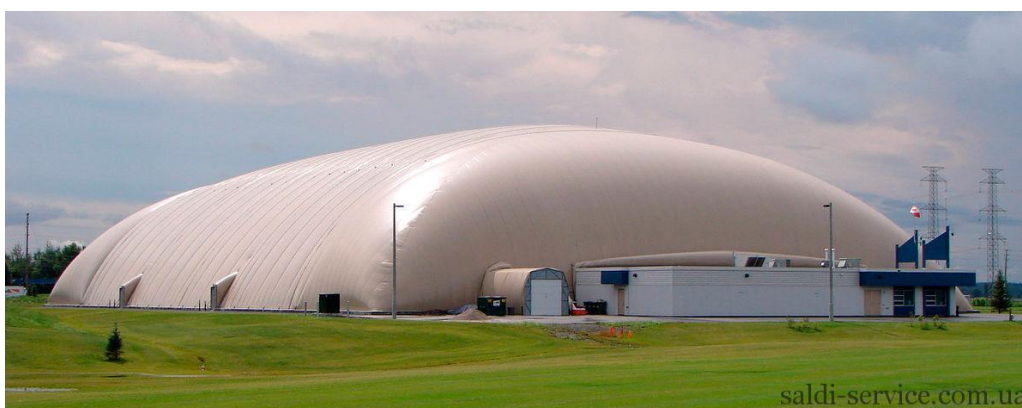
Рис. 3. Пневматическое сооружение с запасными системами жизнеобеспечения
