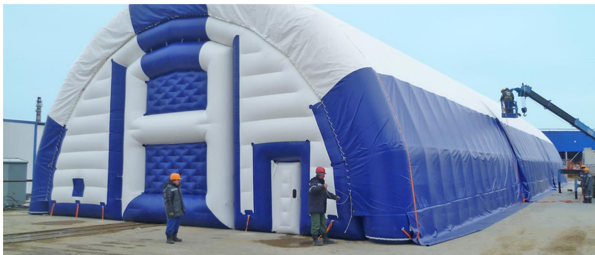
Рис. 2. Воздухонесомое пневмоарочное сооружение
