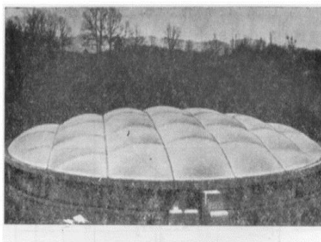
Рис. 3. Пологая оболочка покрытия
