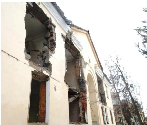
Рис. 1. Снос жилого дома, построенного в начале 50-х годов прошлого века с применением керамического кирпича и «шлакоблоков»
