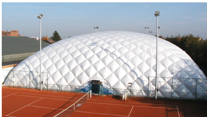
Рис. 1. Воздухоопорное сооружение из ПВХ.
