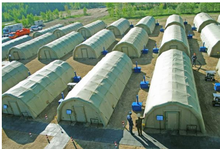
Рис. 4. Пневмоарочные модули аэромобильного госпиталя
