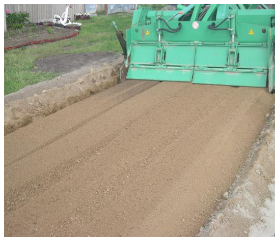
Рис. 1. Укрепление грунта стабилизатором Nanostab
