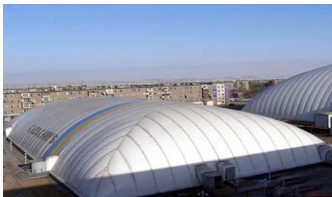
Рис. 2. Воздухоопорное сооружение с оболочкой из кевлара
