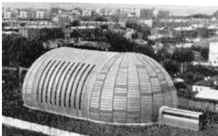
Рис. 2. Воздухопорное сооружение над спортивным объектом США 1968 г.
