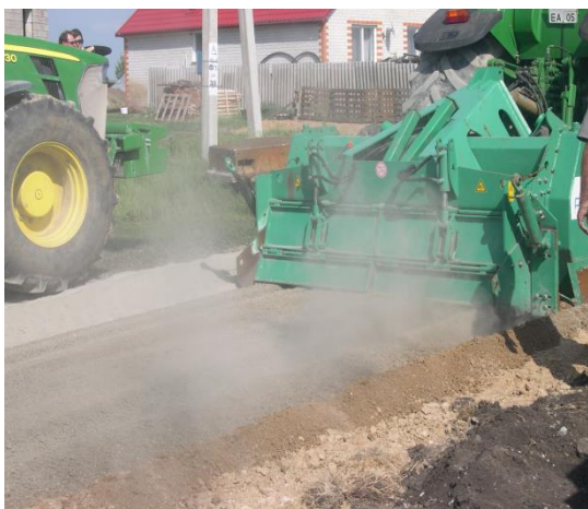
Рис. 1. Укрепление грунта стабилизатором Nanostab
