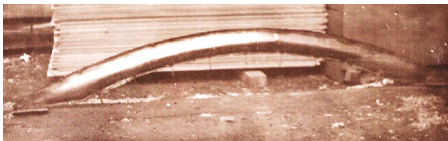
Рис. 2. Модель №1. Арка пролетом 2,0 м и высотой 0,3 м
