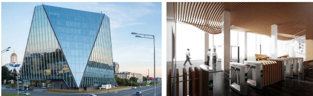
Рис. 4. Офисный центр Eight Edges на Малоохтинском проспекте, 45, (сертификат LEED), г. Санкт-Петербург
