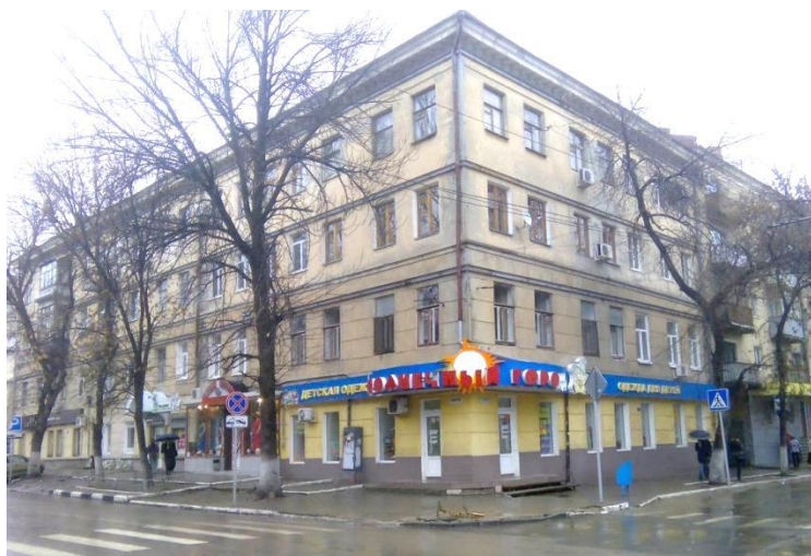
Рис. 1. Жилой дом пересечении ул. Соборная и пр. Котовского в г. Саратове (после усиления, по состоянию на 10.11.2015 года)
