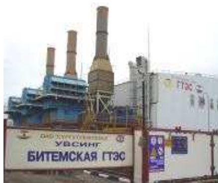
Рис. 2. вид ГТЭС с газотурбинной установкой ГТУ-4П
