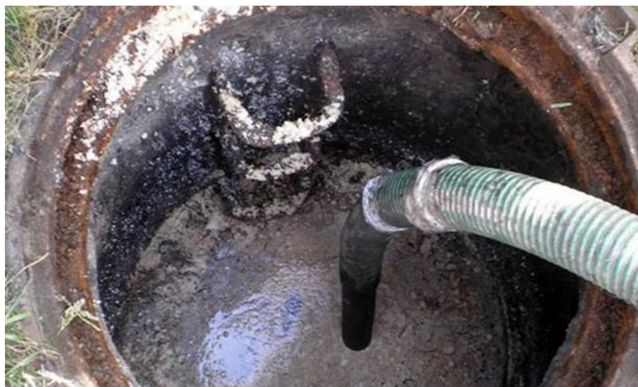
Рис.1. Жиросодержащие стоки в канализационной магистрали
