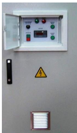
Рисунок 1. Станция управления с частотно-регулируемым приводом
