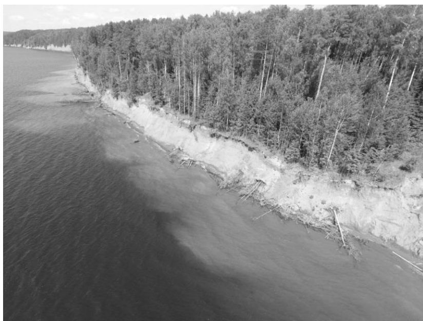
Рис.3. Участок абразионного берега Воткинского водохранилища
