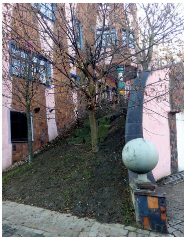
Рис. 6. Состояние деревьев и травянистого покрытия на наклонном участке кровли при входе в здание Зеленой цитадели
