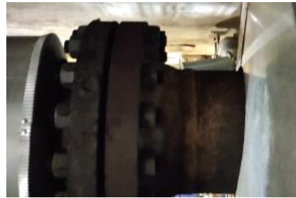
Рис. 12. Фланцевое соединение теплообменника
