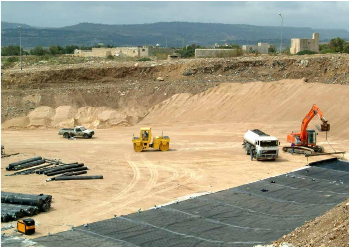
Рис. 37. Экранирование токсичных пород и защита дна и берегов от фильтрации
