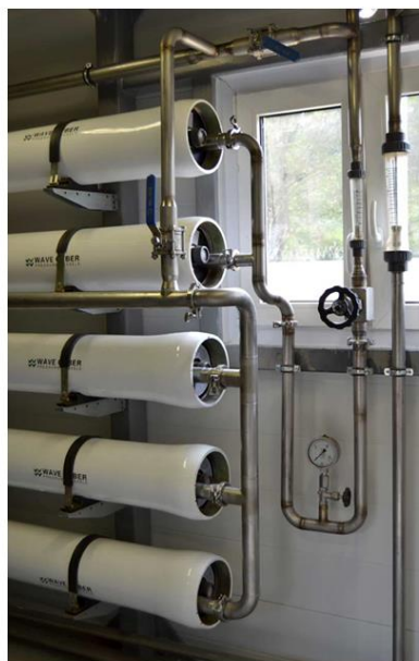
Узел обеззараживания сточных вод озонированием
