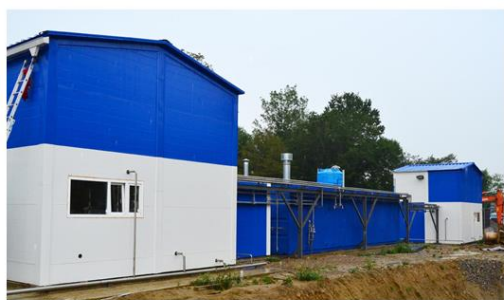
Общий вид зданий: параллельно работающие и технологически связанные Станции очистки стоков (СОС 1 и СОС 2), общей производительностью 400 м 3 в сутки.
