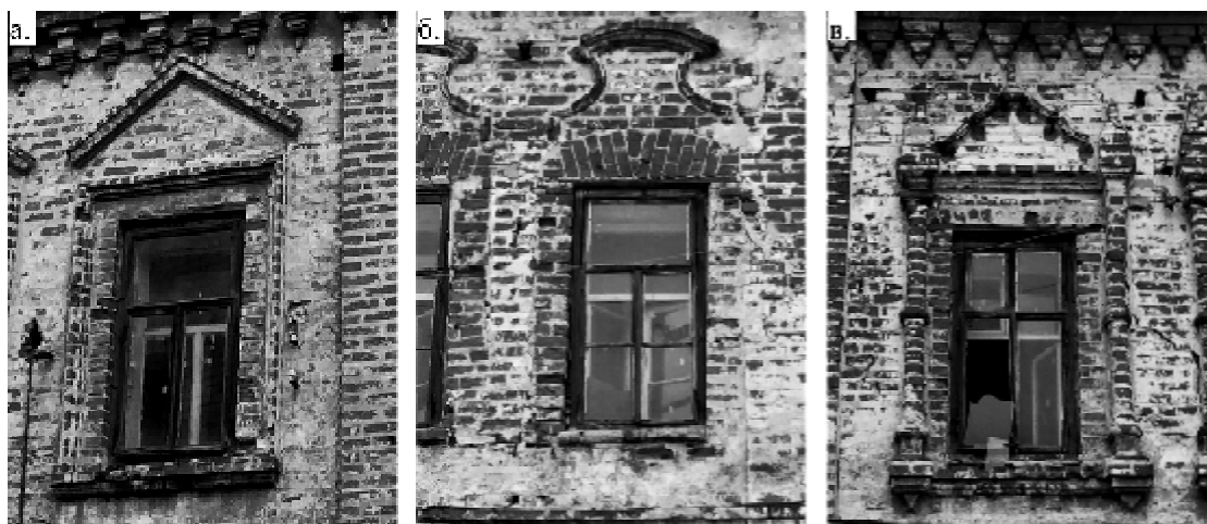
Рис. 8. Декоративные обрамления оконных проемов второго этажа: а. в осях 1-3/Б и 1/Б-И; б. в осях 10-12/Б; в. в осях 4-6/Б, 13-18/Б и 18/Б-И [3]
