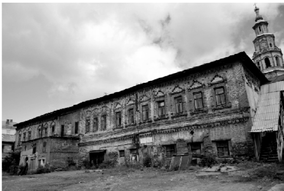
Рис. 1. Общий вид фасада в осях А/5-10 и Б/1-18 (со стороны ул. Профсоюзная) [3]
