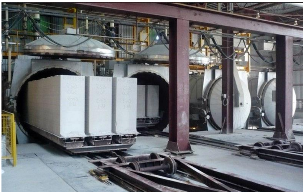
Рис.1. Цех по производству автоклавного газобетона
