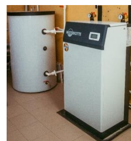
Рис. 3. Тепловой насос WATERKOTTE EcoTouch DS 5027 Ai
