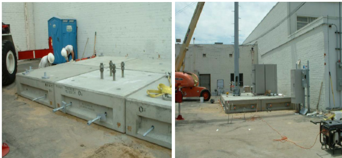
Рис. 3. Система сборно-разборного фундамента системы «Cell block».
