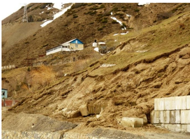
Фото 1. Оползень в долине р. Мамисон.
