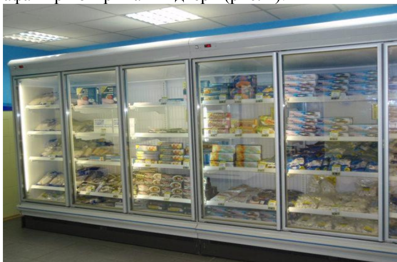
Рис. 1. Холодильное хранение мороженой рыбной продукции в шкафу-витрине марки Z86 с распашными дверями
