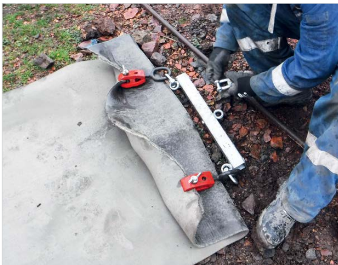
Рис. 3 — Протяжка бетонного полотна под низкопролегающими трубами
