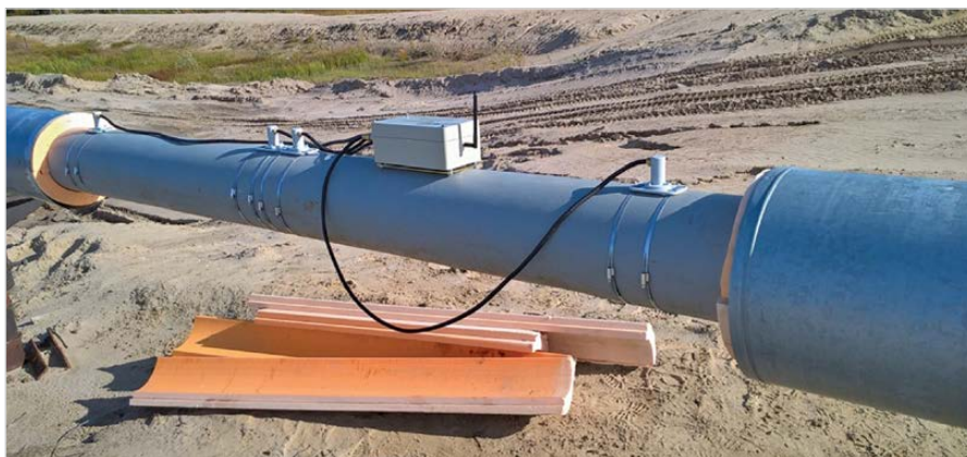
Рис. 3 — Фото датчика сигнализатора «Кадет», установленного на кусте скважин Губкинского газового месторождения
