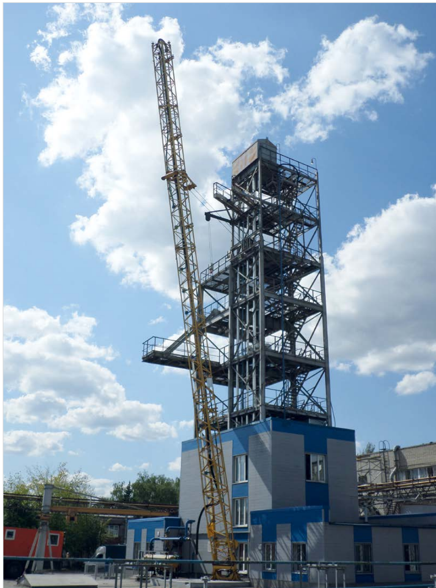
Рис. 2 — Стенд для исследований вертикальных, наклонных и горизонтальных газожидкостных потоков
