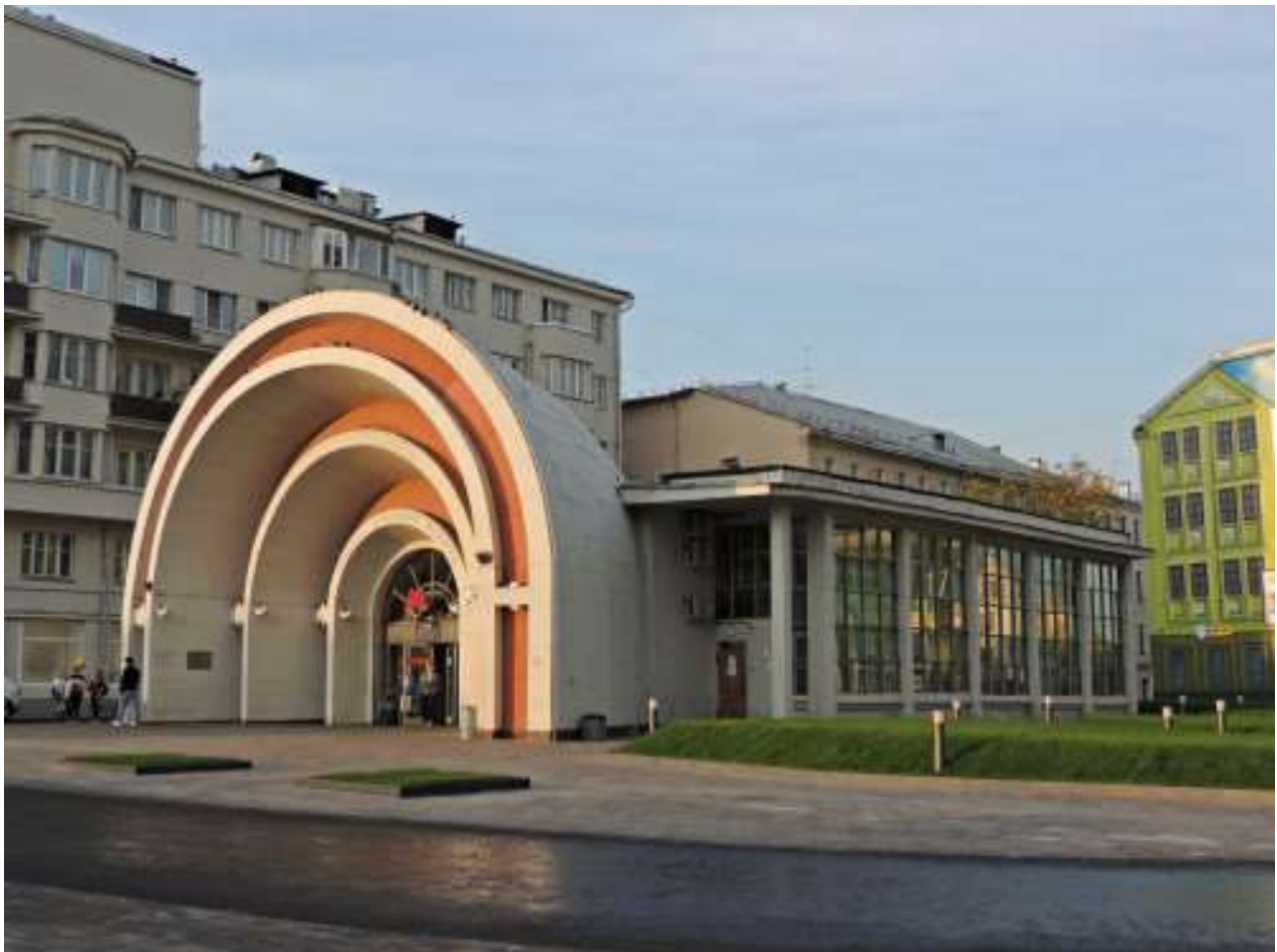
Рисунок 3. Наземный павильон станции метро «Красные ворота»
